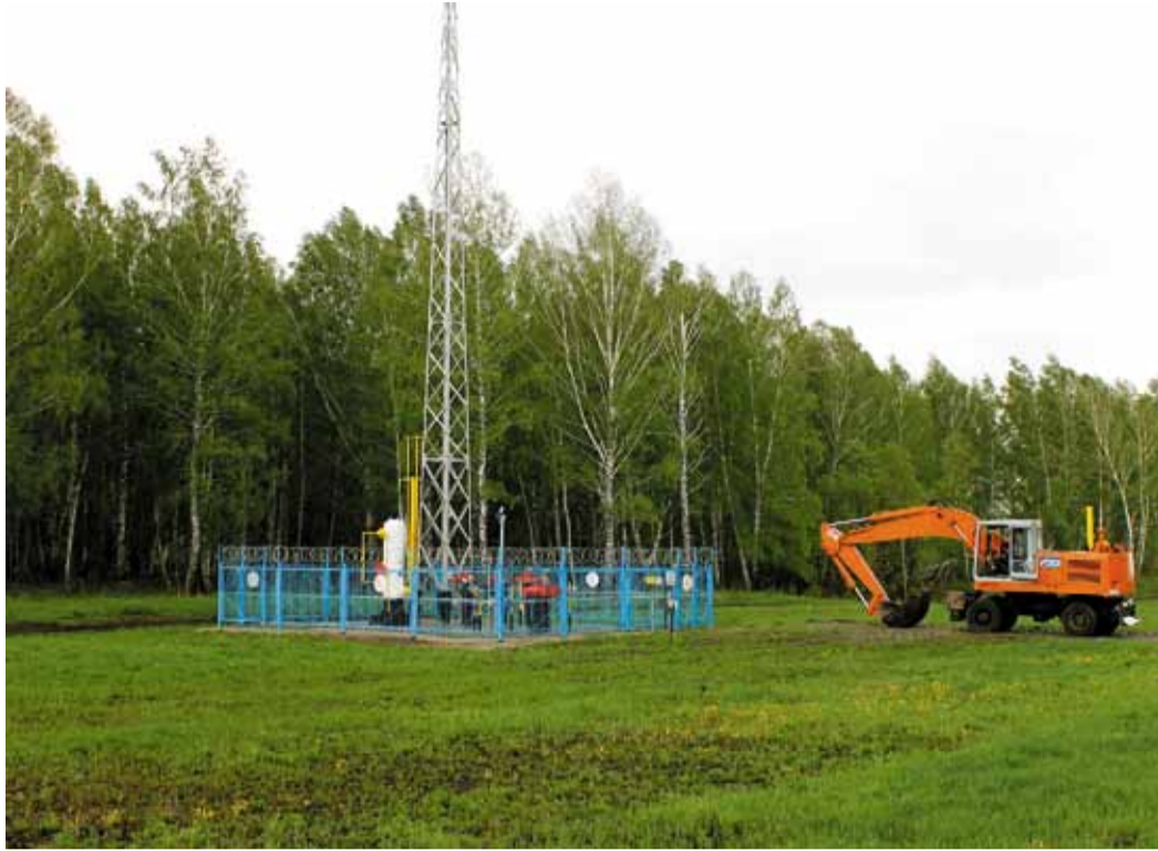
Ремонтные работы на участке Юргинского ЛПУМГ
